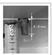
Verificare che la sporgenza delle barre filettate M12 dalla parete sia pari a spessore della ceramica 'X' - 8 mm.
