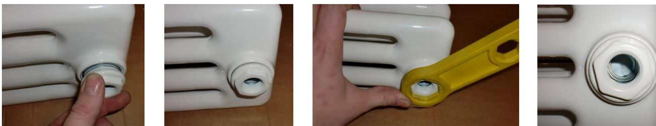
L'installazione è completata ed il diaframma Comby può svolgere la sua funzione, cioè deviare il flusso d'acqua dall'ingresso del mozzo inferiore verso il mozzo superiore della batteria, ripristinando la normale funzionalità dello scambio termico del corpo scaldante che prevede l'ingresso (mandata) dall'alto.
