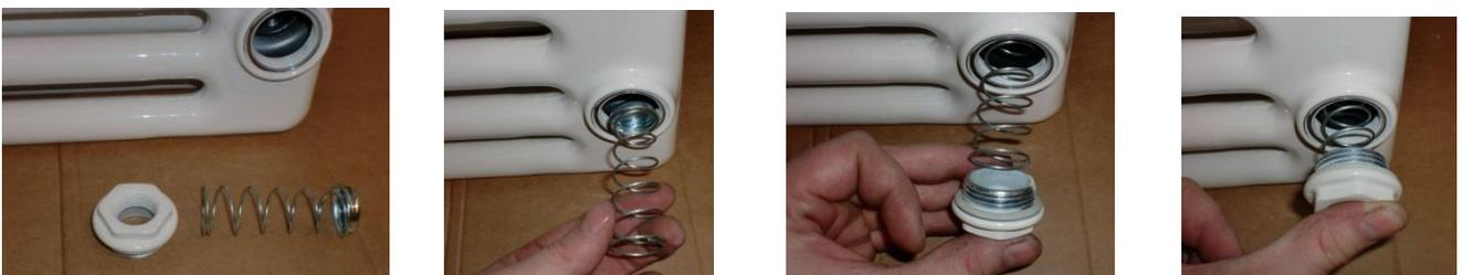
Una volta inserito il piattello ed avvitata la riduzione al mozzo, la molla viene schiacciata e mantiene il piattello pressato contro il mozzo tra il primo ed il secondo elemento della batteria, impedendo il passaggio d'acqua attraverso il mozzo inferiore.
